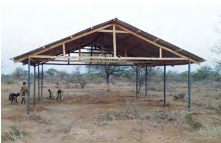
Baubeginn eines Schulgebäudes
