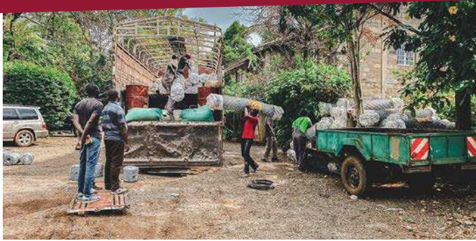
Das Material zum Bau des Zaunes wurde in Eldoret geladen und in den Südsudan transportiert
