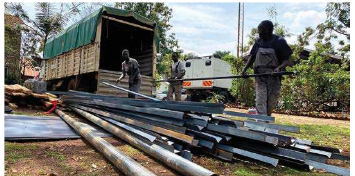
Materiel zum Bau der Sanitäranlage und des Zaunes musste in Eldoret gekauft und dann mit einer dreitägigen Autofahrt in den Südsudan transport werden.
