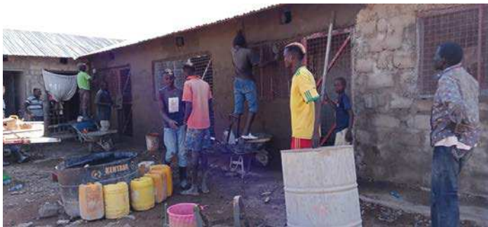
Bei der Fertigstellung des Konferenzentrums mit Gästezimmer
