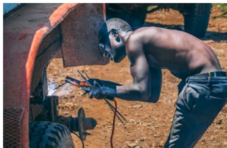
Schweißerarbeiten mitten im Busch
