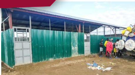
Fertiggestellte Halle im Südsudan
